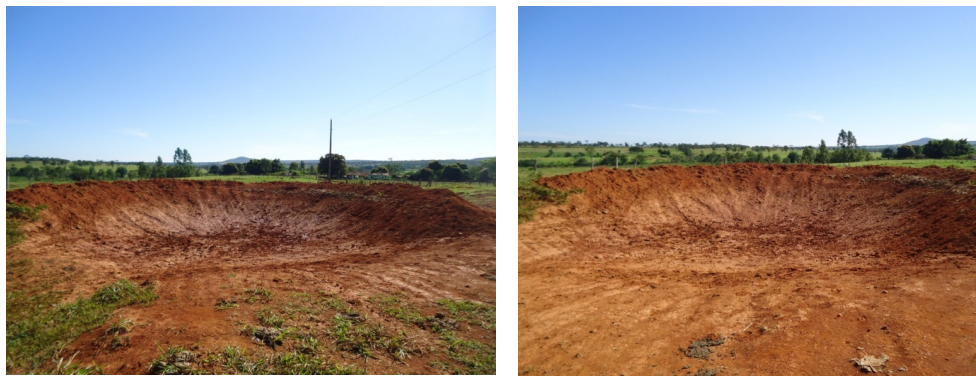
Figura 2-1: Barragem construída através da EMBRAPA em parceria com a Prefeitura Municipal de Morro da Garça Fonte: GERHI (2013)
