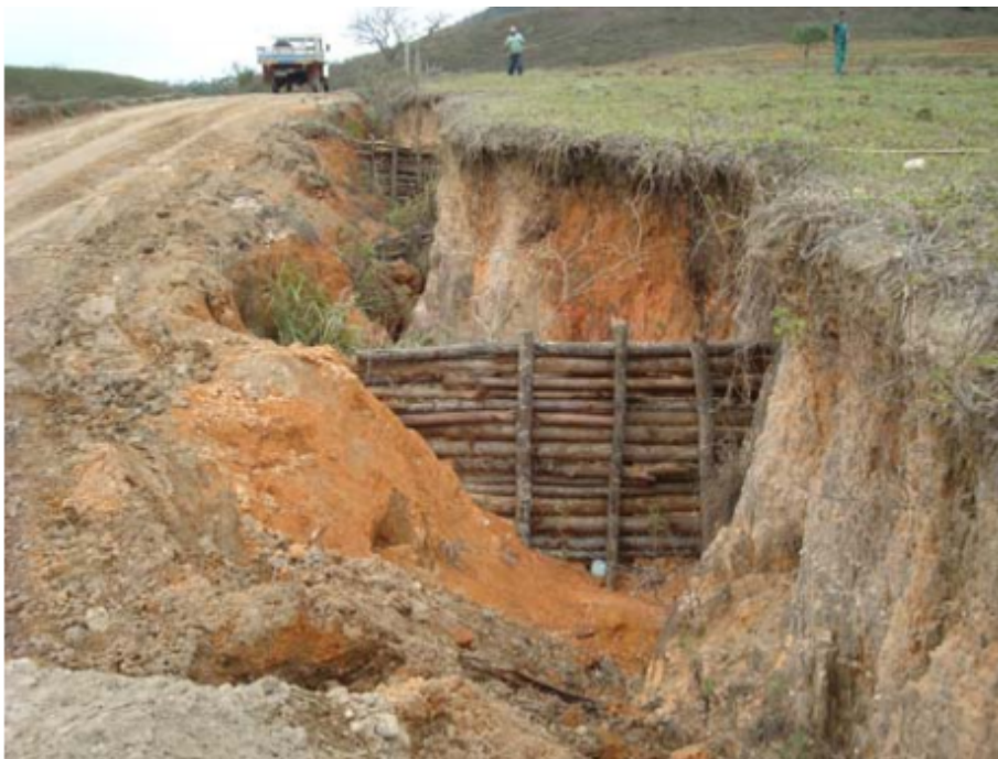
Foto 1: Paliçada de eucalipto Fonte: SAAE Itabira (2010)
